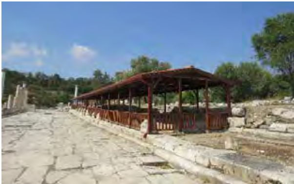
Resim 4: Kuzey Sütunlu Cadde kenarında üst örtü uygulaması.
