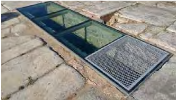
Resim 6: Kuzey Sütunlu Cadde kanalizasyonu üzerine yürünebilir temperli cam ve demir ızgara zemin.
