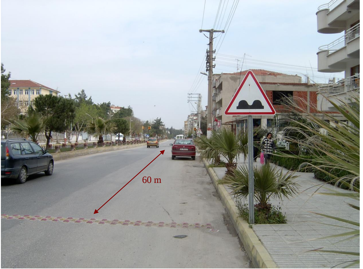
Resim 6. Mehmetcik İlköğretim okulu önünde trafik yavaşlatma uygulaması.
