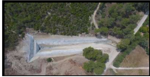
Şekil 124:Kaş Kasaba Kıbrıs Barajı Projesi Çalışması [URL 86]
