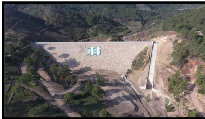
Şekil 129: Adrasan Baraj Projesi URL 88]
