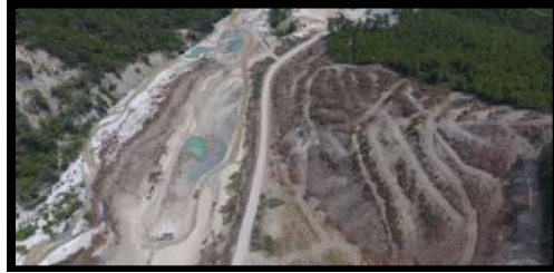
Şekil 123: Kaş Kasaba Kıbrıs Barajı Projesi Çalışması [URL 86]
