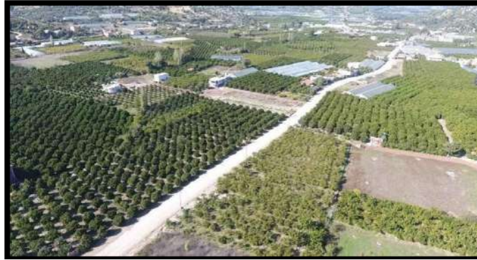
Şekil 128: Adrasan Baraj Projesi [URL 88]
