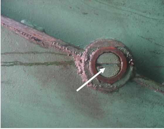
Şekil 8. Sökülmesi için özel takım gerektiren bağlantı elemanı seçimi
