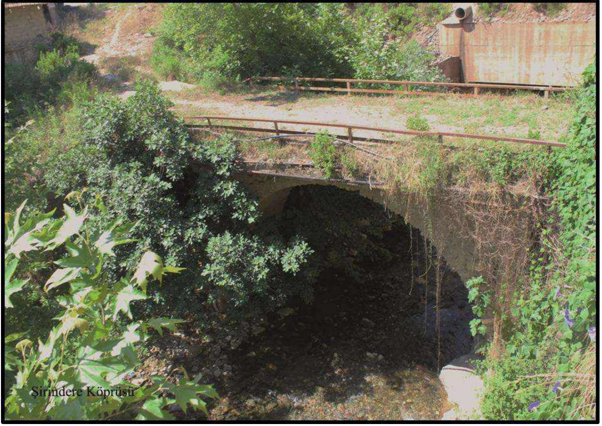
Şekil 43:Şirindere Köprüsü. [T-URL-25]
