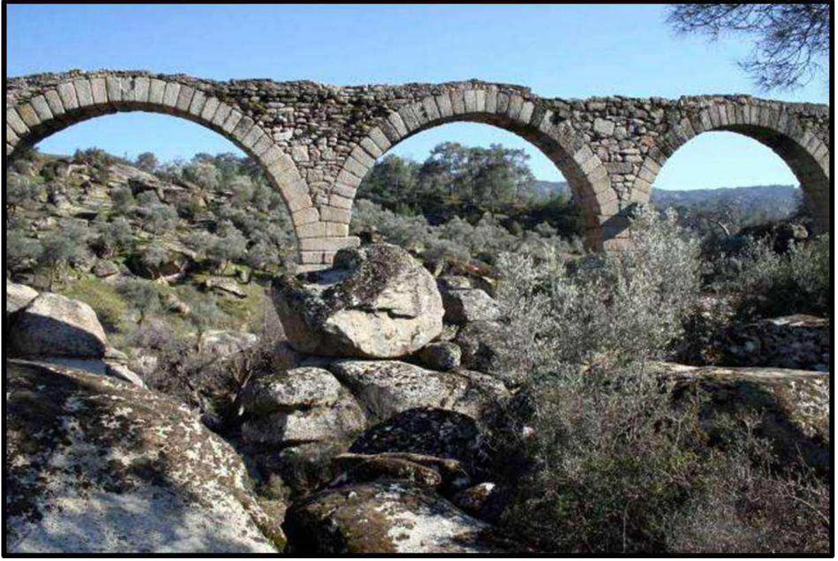
Şekil 25:Çine İnce Kemer Köprüsü.[T-42]
