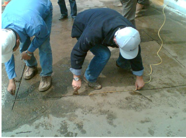
Resim 5. Sensör kanallarına kablo yerleştirilirken
