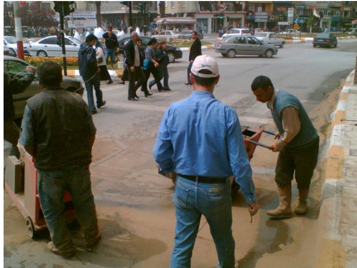
Resim 4. Asfalt makinası ile kesim yapılırken
