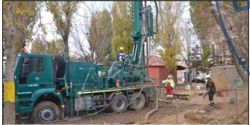
Muş'un 100 yıllık içme suyu sorununa sondajlı çözüm
