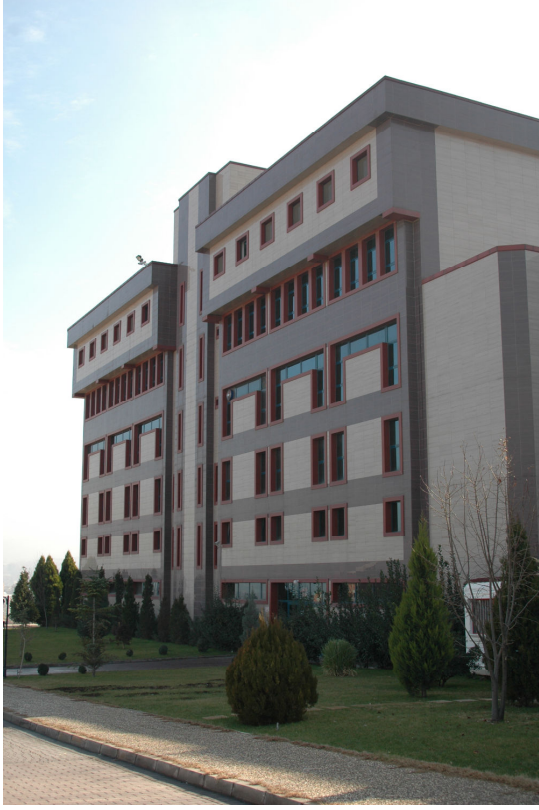
Morfoloji Binasının güney cephesinin görünümü
