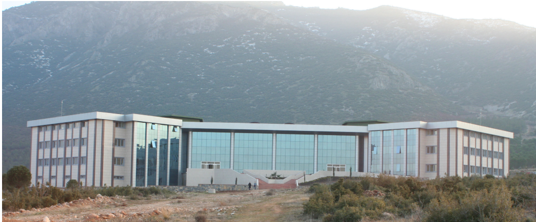
Rektörlük binası kuzey cephesinin genel görünümü
