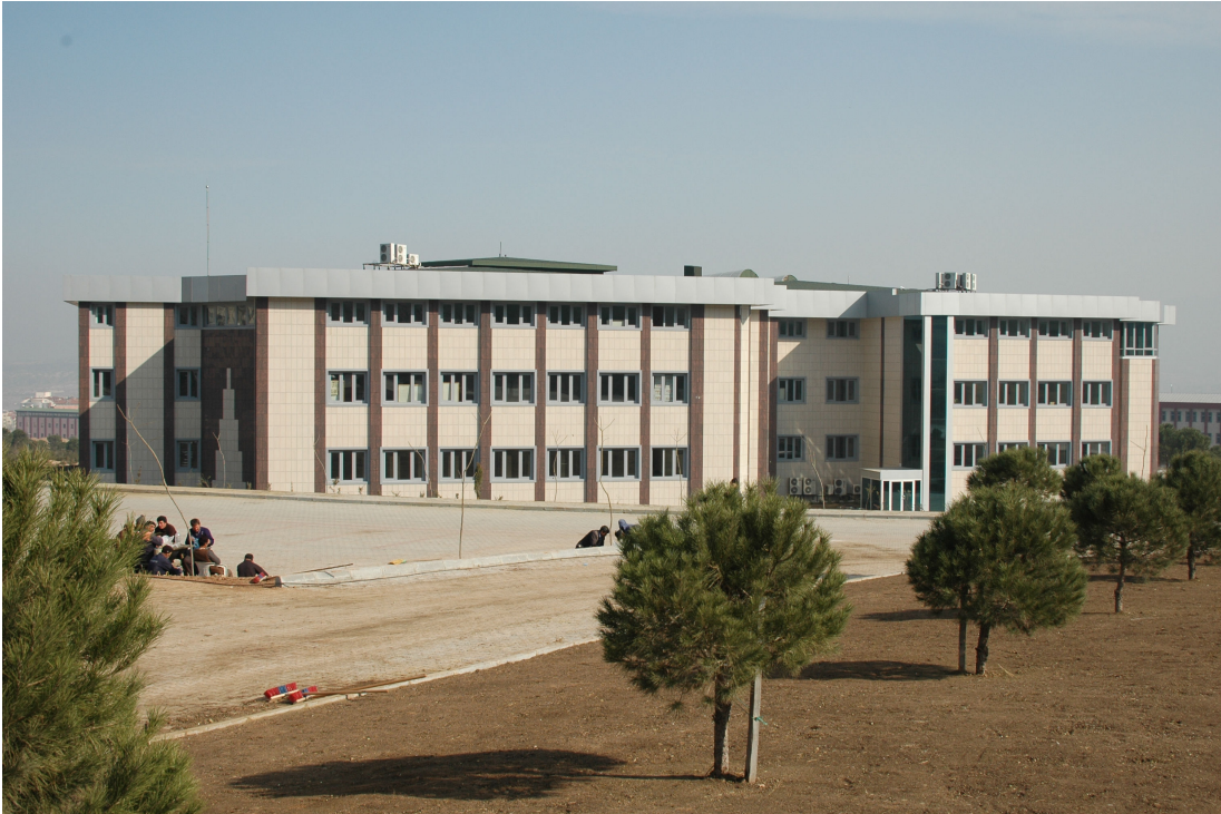
Rektörlük binası güney cephesinin genel görünümü
