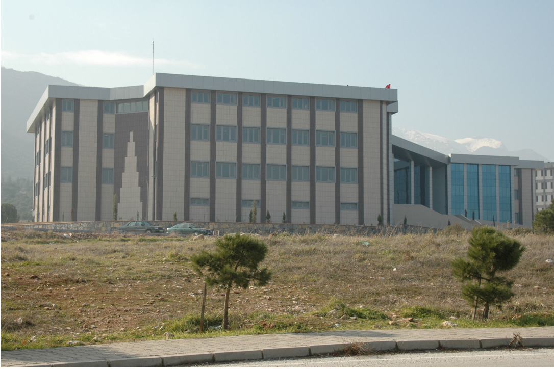
Rektörlük binası doğu cephesinin genel görünümü
