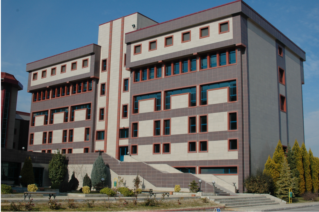
Morfoloji Binası kuzey bloğunun genel görünümü
