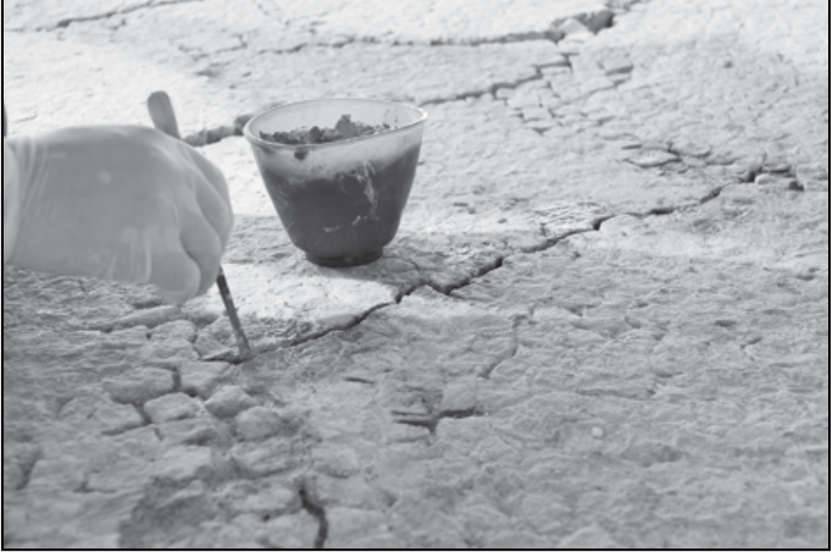
Resim 8: Doğu Portik taban mozaïği, 2 numaralı panel, çatlak dolgu uygulaması.
