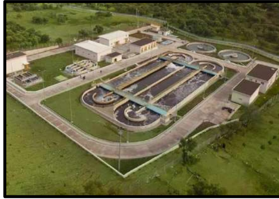
Şekil 165: Atık Su Arıtma Tesis Yatırımları- [E-25]
