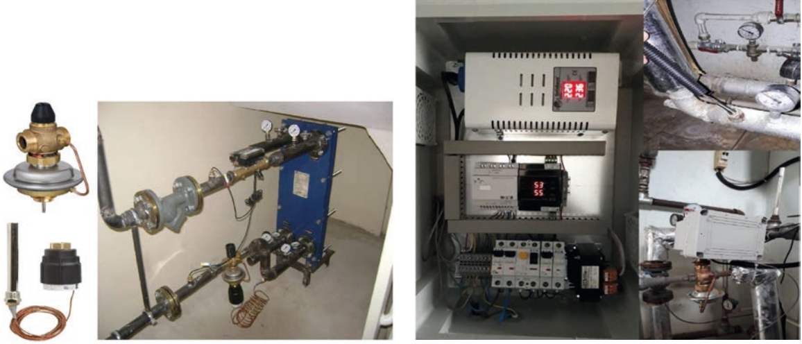
Şekil 26. Bina altı enerjiden bağımsız debi kontrol sistemi [89]
