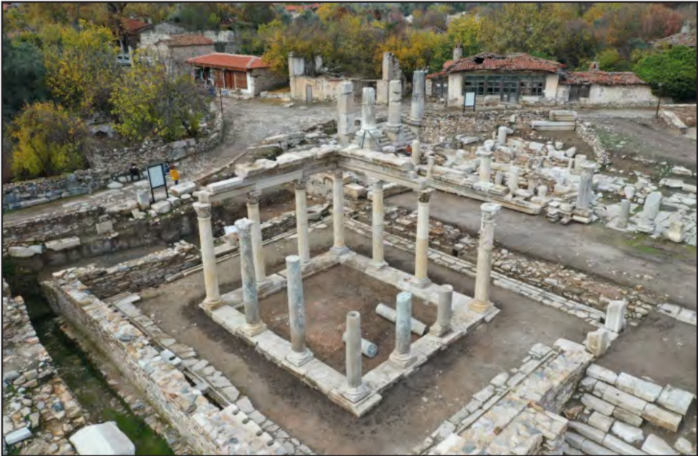
Resim 4: Çalışmalar sonrası latrina nın ve çevresinin havadan görünüşü.
