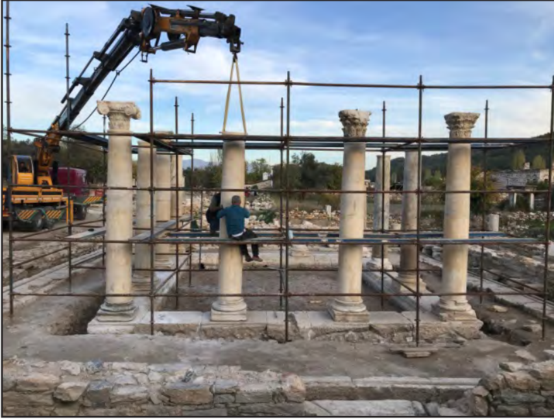
Resim 3: Latrina sütunlarının restorasyon çalışmaları.
