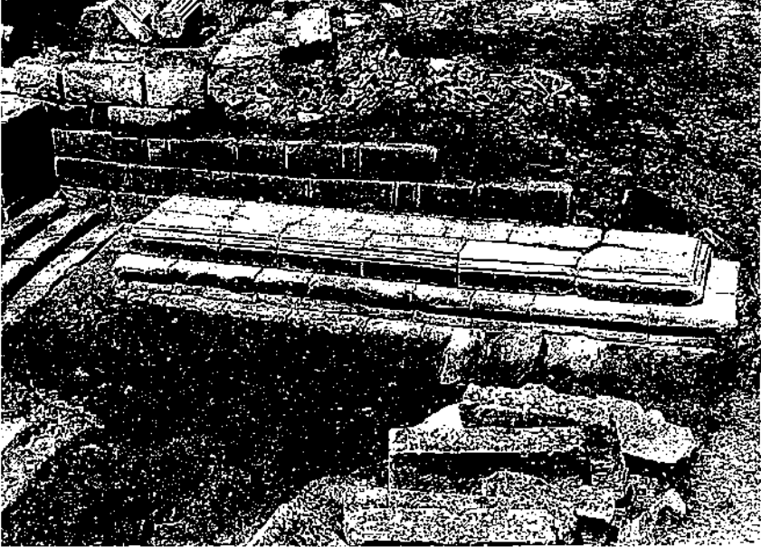
Resim 14: Heykel kaidesi platformunun restorasyon sonrası
