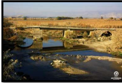
Şekil 116.Ahmetli Köprüsü (SARAYKÖY), [URL 6]
