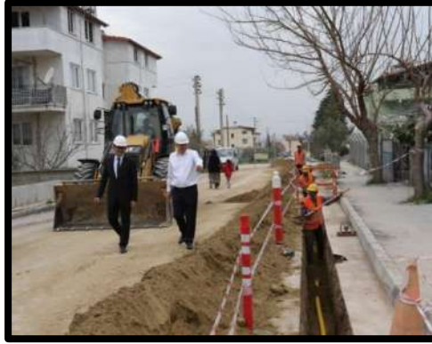
Şekil 382 Doğalgaz Projesi (DBB Arşiv-Projeler)
