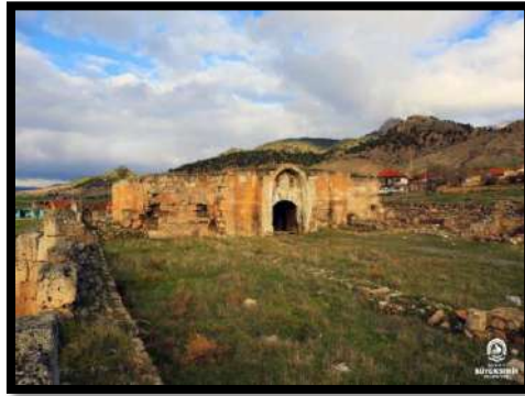
Şekil 143.Çardak Kervansarayı, [URL 6]
