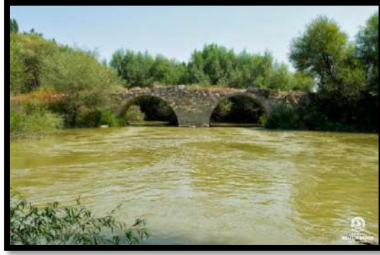
Şekil 107.Dayılar Köprüsü (Tozlukara Köprüsü) (ÇAL)
