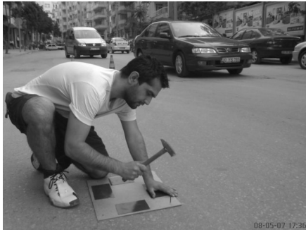
Resim 1. Cihazın asfalta monte edilmesi
