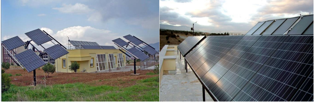
Şekil 7.2 Temiz Enerji Evi
