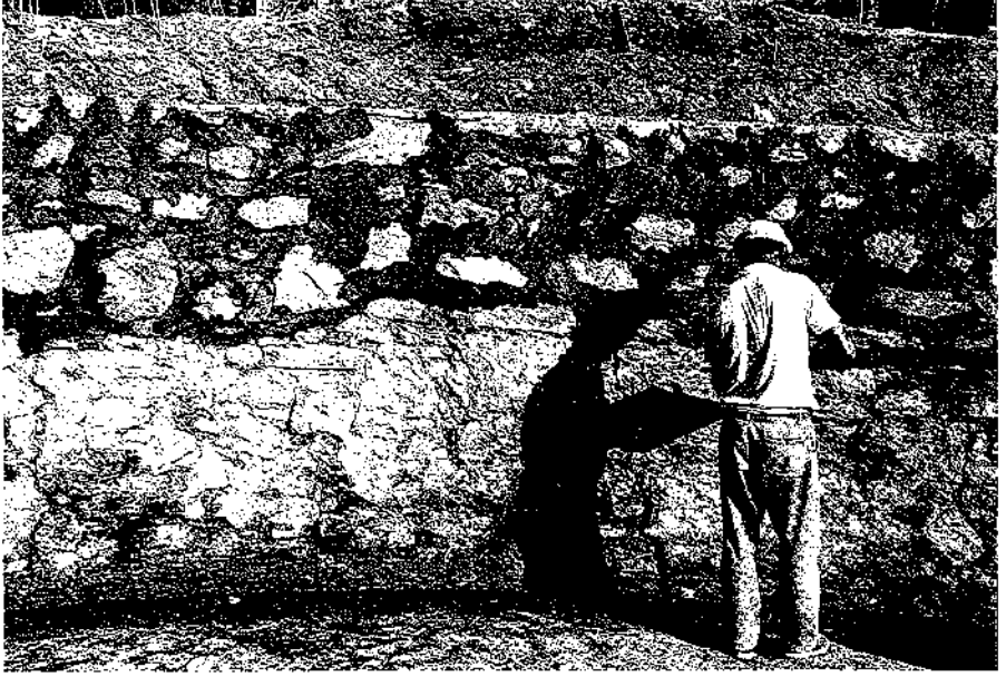
Resim 17: Havuz restorasyon çalıřmaları
