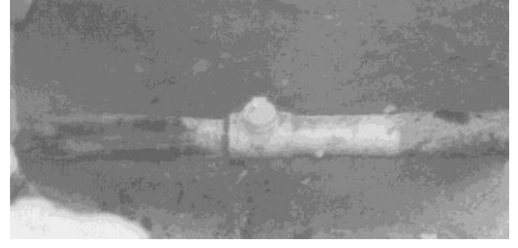
Şekil 1. Vida eklemeli gaz boru hattındaki hasar [5, 6]
